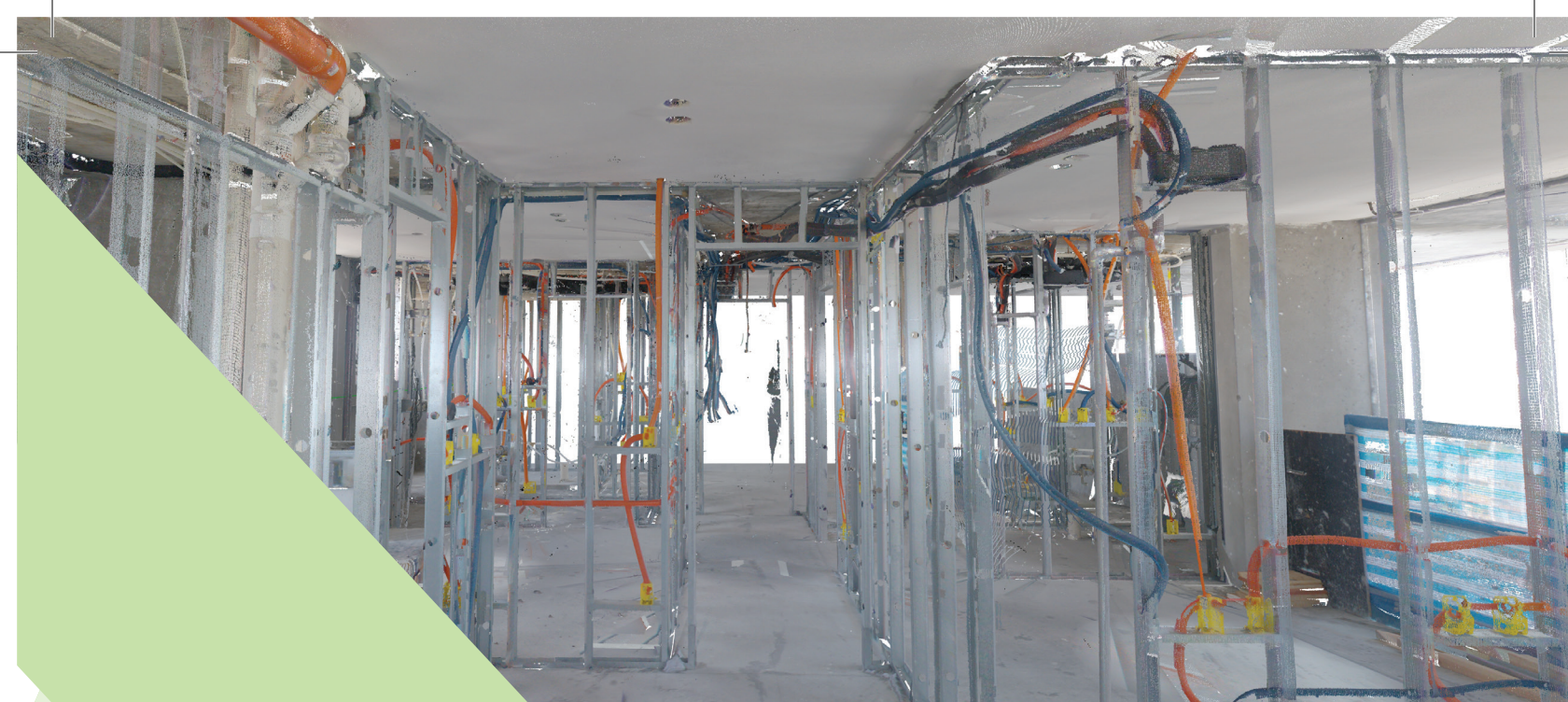
Figura 07 -Escaneamento de infraestrutura de sistemas para cálculo de materiais e as built. Fonte: AMITECH
